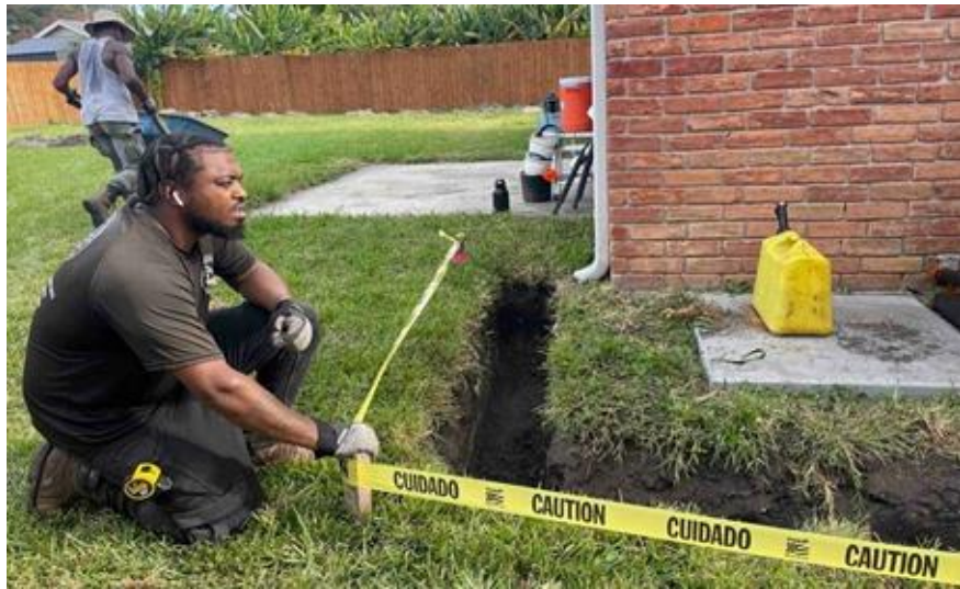
Thi Công Hệ Thống Thoát Nước Ngầm trên Jahnke Road
