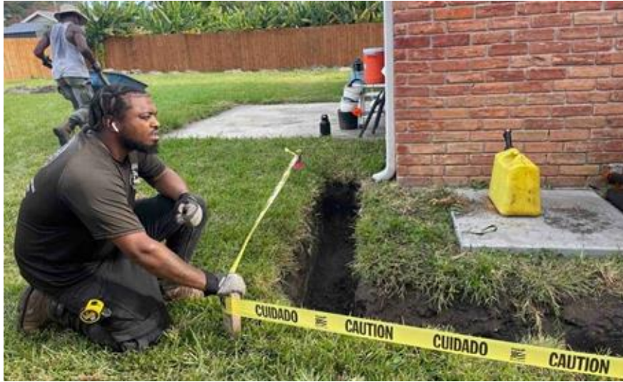
Instalación de drenaje francés en Jahnke Road
